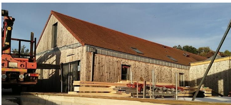
Début des travaux
